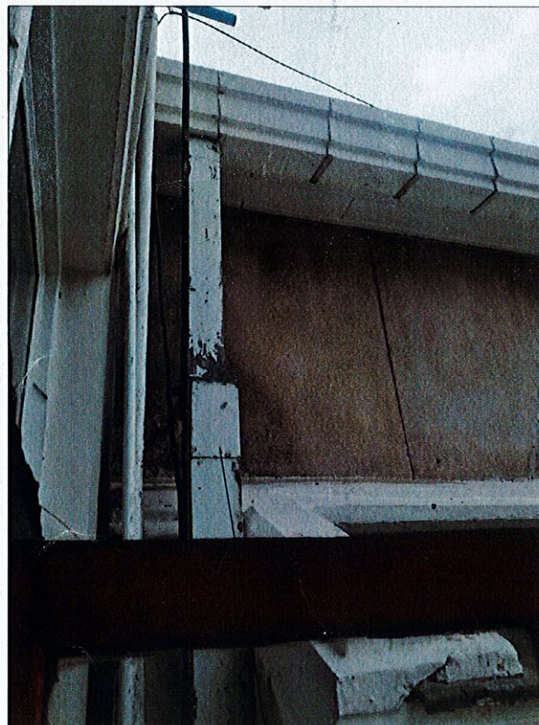
เปลี่ยนใส่ท่อระบายน้ำสแตนเลส 8*8" ทาสีภายนอกใหม่
